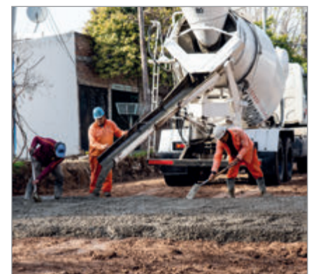
Las obras integrales tienen una extensión de 2,9 kilómetros
