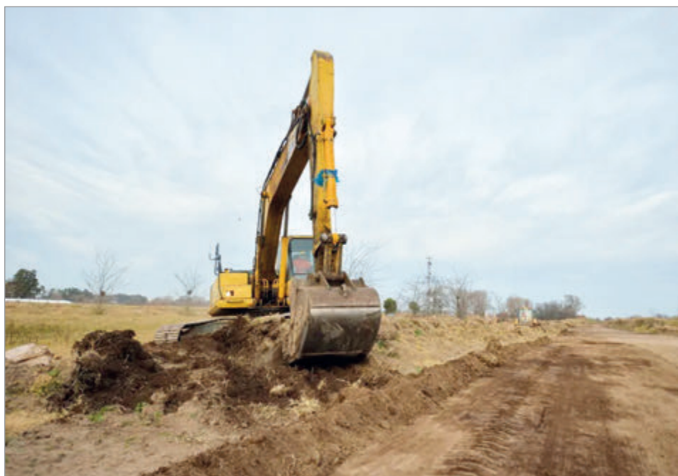
Kicillof dio inicio de los trabajos sobre casi 50 km de la “Ruta del Cereal”
