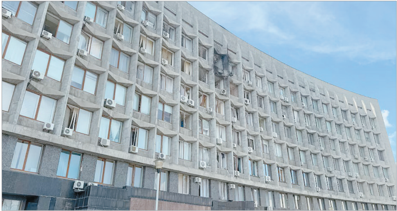
El edificio de la Administración Militar de Sumi fue alcanzado por drones rusos
