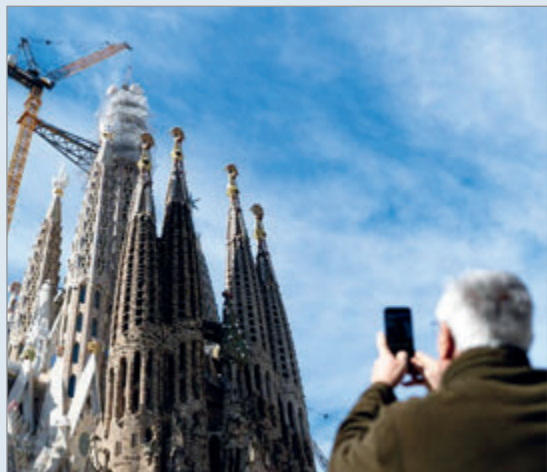
Cientos de turistas siguieron desde el exterior las maniobras para colocar la estructura
