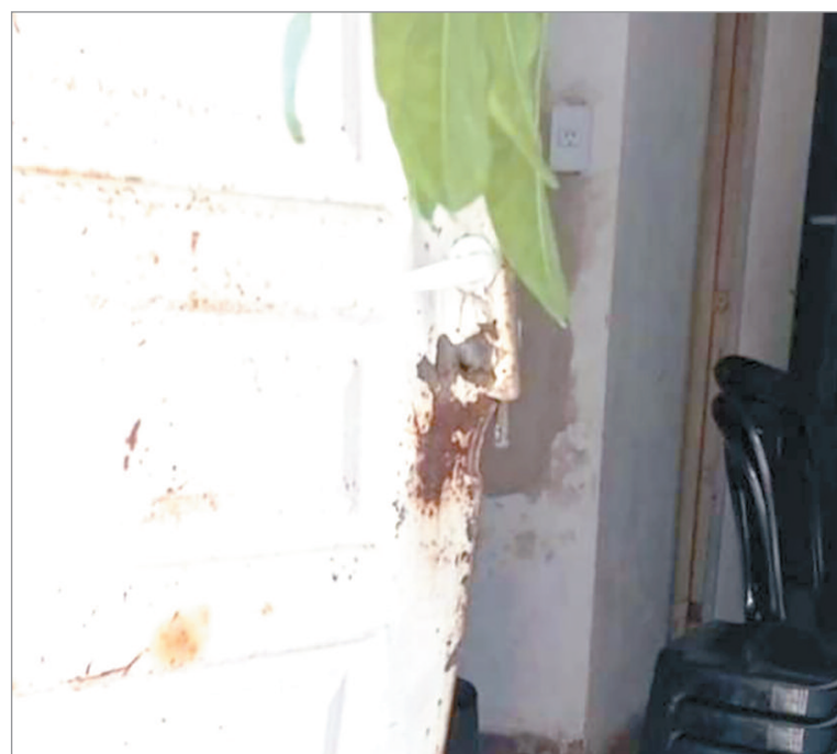
La puerta forzada
