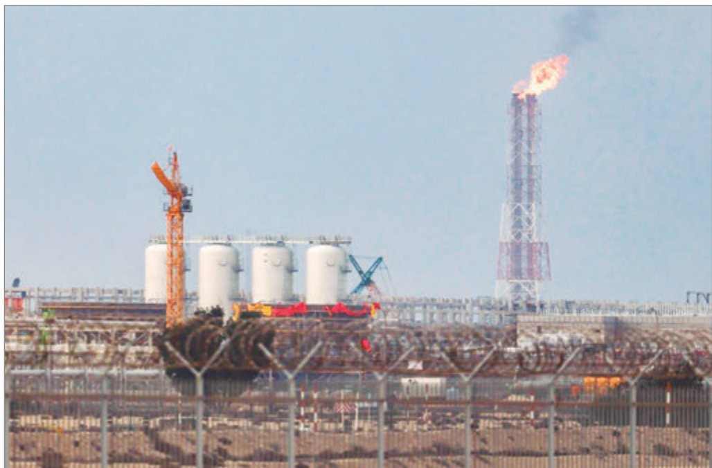
El ataque a Qatar afectó directamente a Argentina
