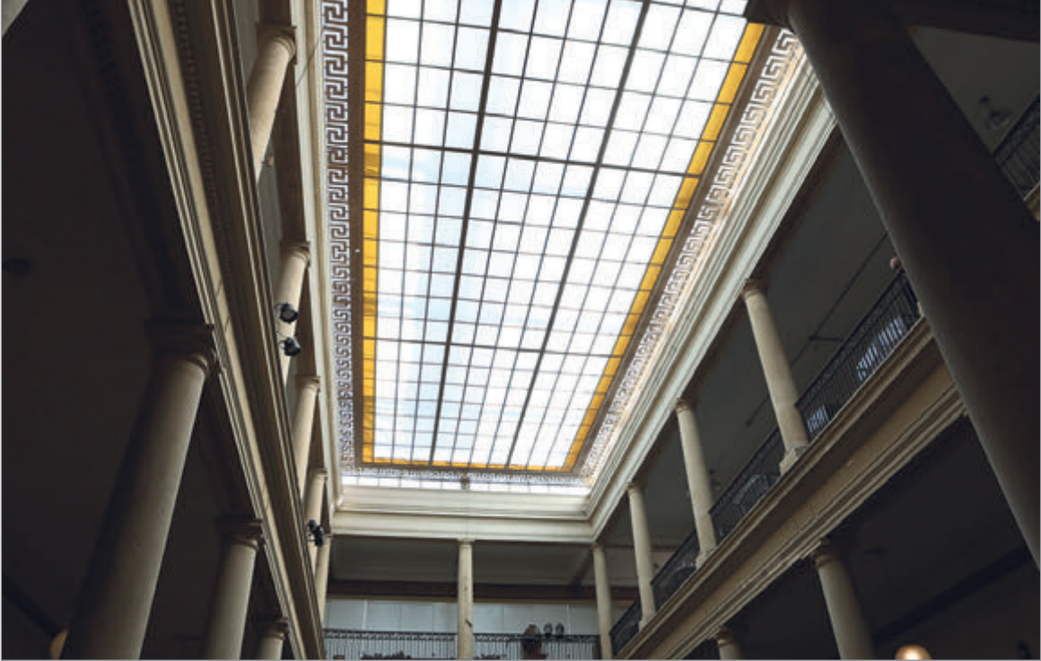
Los trabajos incluyeron la recuperación general de las cubiertas y lucernarios del edificio
