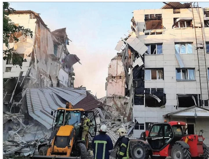
Equipos de rescate trabajaron durante horas entre los restos del edificio
