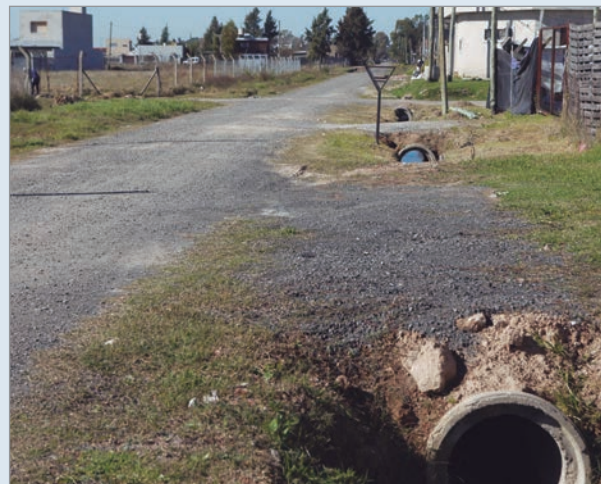
Las tareas se desarrollan sobre calle 6 desde 470 hasta diagonal 16 y en diagonal 16 entre 5 y 6
