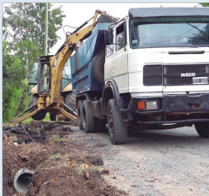
Los trabajos contemplaron el recambio de cañerías en entradas domiciliarias
