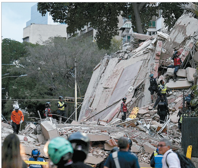
Residentes de Caracas abandonaron edificios tras el fuerte movimiento
