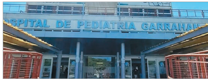
Cinco Arcos en C de última generación refuerzan la capacidad de los quirófanos pediátricos
