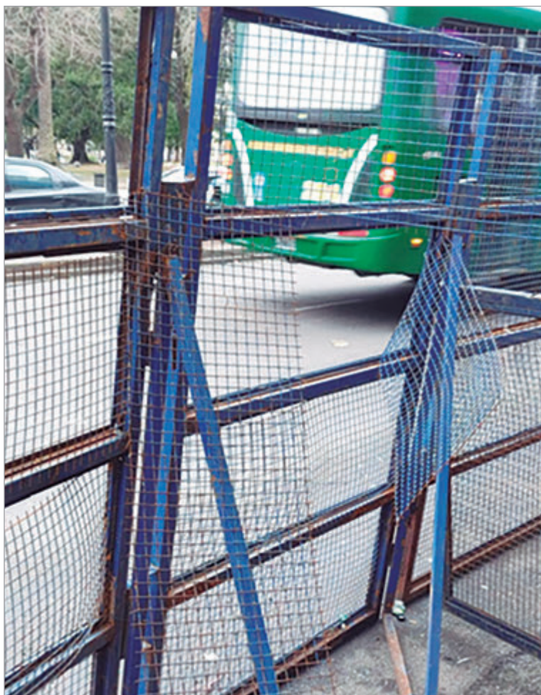
Parte de los destrozos
