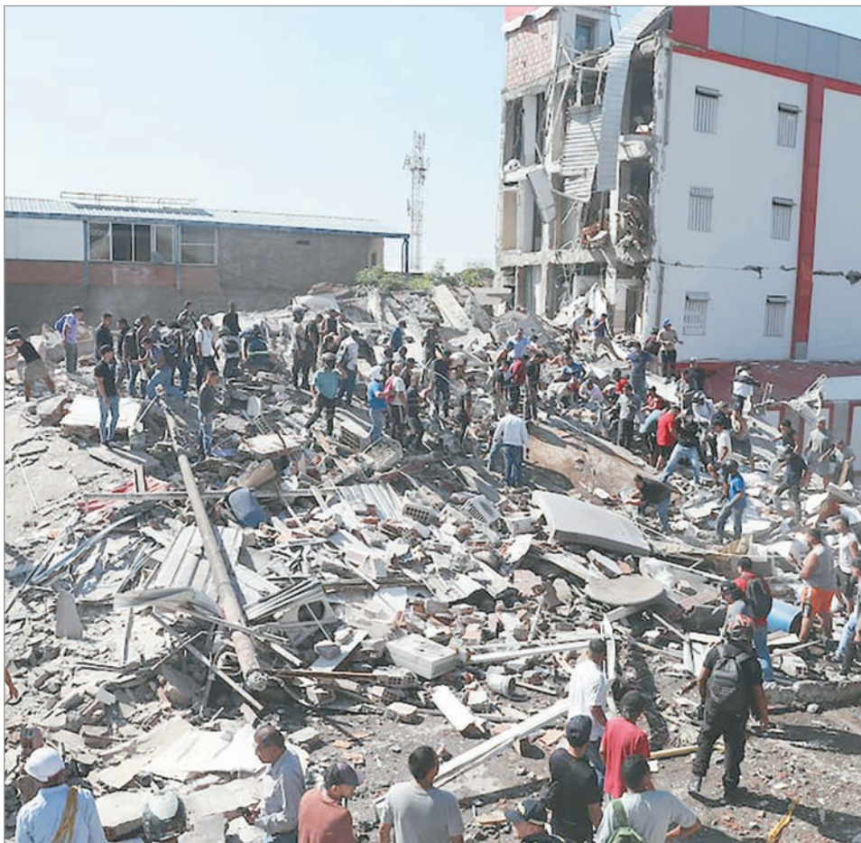
Emergencia en Colombia
