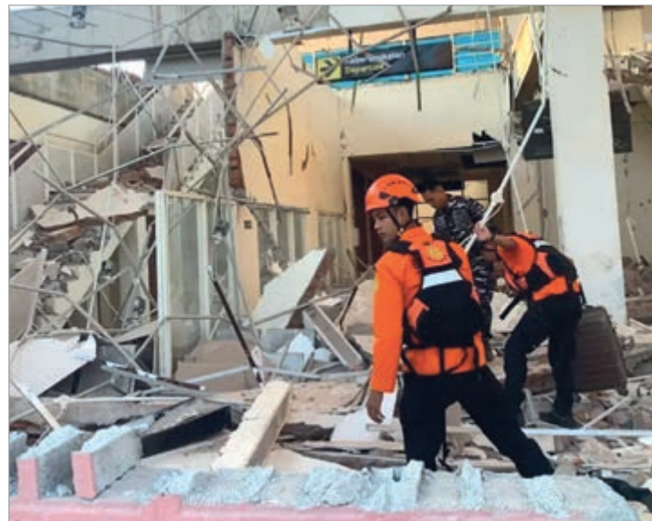
Los equipos de emergencia trabajan entre los escombros en las zonas más afectadas
