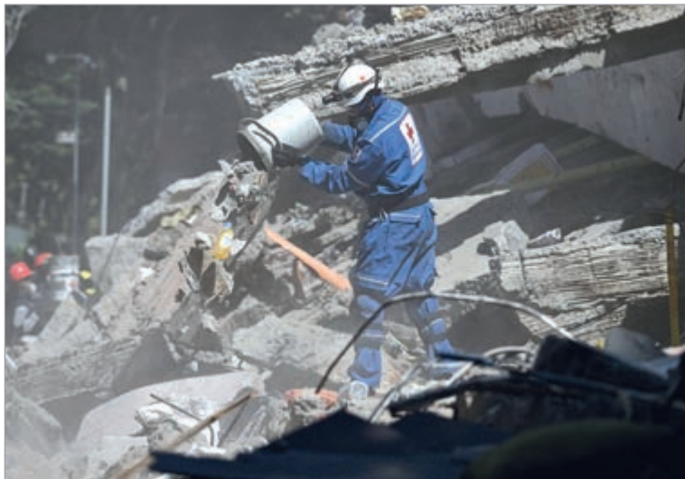
Equipos nacionales y extranjeros continúan trabajando entre los escombros en las zonas más afectadas por el sismo
