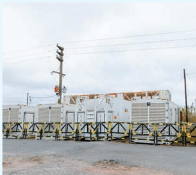
Continúan los trabajos para recuperar el servicio de manera progresiva
