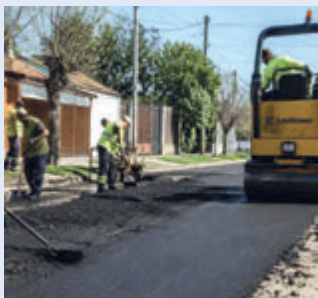
Trabajos de reparación de calles en City Bell, Villa Castells y Altos de San Lorenzo
