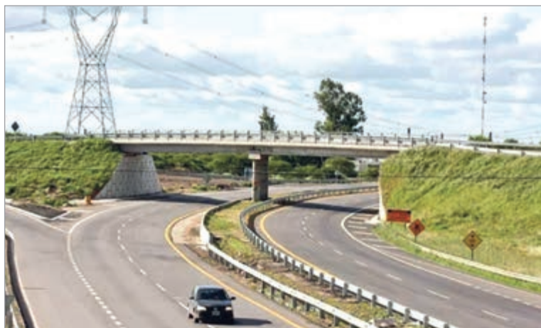
El Ejecutivo completó el traspaso a privados de más de 9000 kilómetros de rutas nacionales
