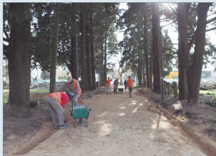
Los trabajos se desarrollan tanto en el interior como en el perímetro del predio
