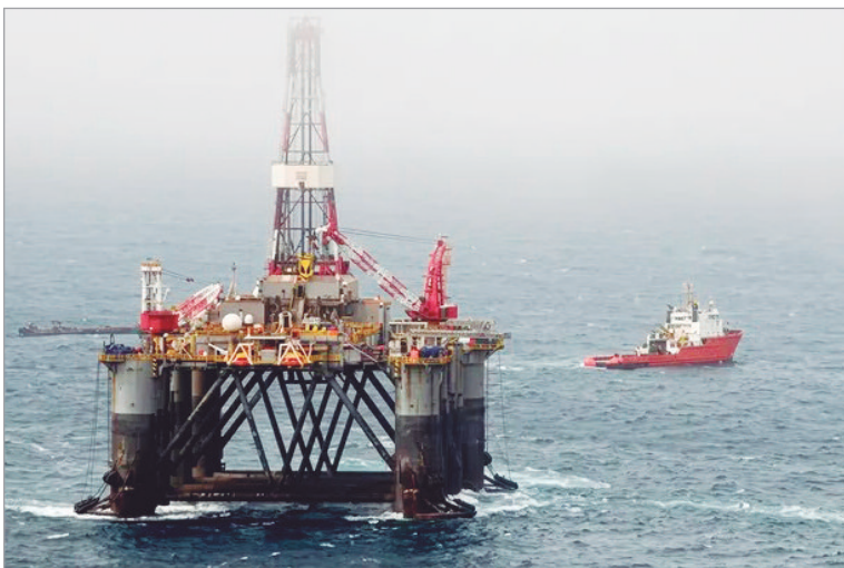
La medida alcanza perforaciones, extracción e infraestructura asociada
